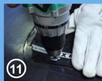
Die Unterseite mit FIX'N GO® montieren. Abwechselnd alle Schrauben an Seite und Reihe verschrauben
