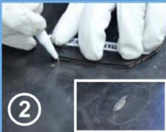
FIX'N GO auf die Risse setzen (Oberseite des Band)
