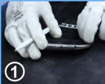
Schneiden Sie FIX'N GO® so zu, dass Sie mindestens 2 Reihen für die Schrauben haben.
